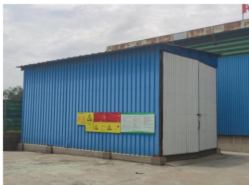
厂区西南角的危废库
