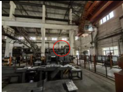
三车间 6#900KW电炉
