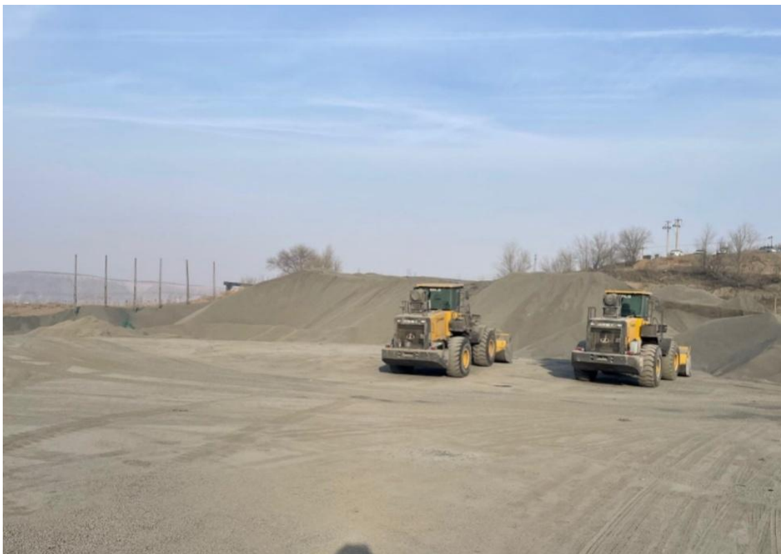
照片 1-10 工业广场治理情况
