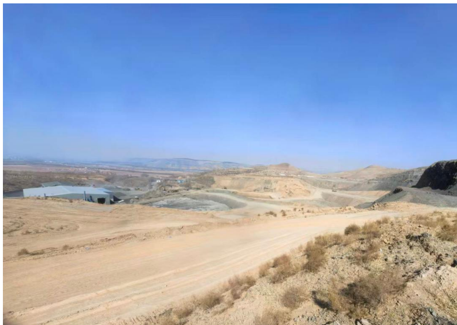
照片 1-7 矿区道路
