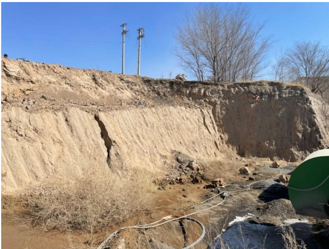
照片 1-12 办公生活区（切坡区域）治理情况
